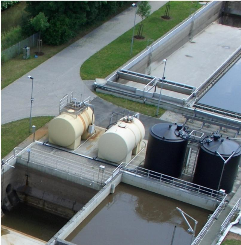
Chlorid und eine Aluminiumchloridlösung. Ersteres dient nebenbei zur Eliminierung von Schwefel, der ebenfalls gefällt wird (Schutz des BHKW). Aluminiumchlorid führt zusätzlich zur Verbesserung der Schlammabsetzeigenschaften, da das Wachstum fadenbildender Bakterien unterdrückt wird (Elimination Microtox).
