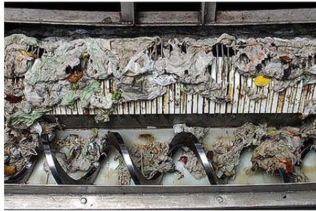
Die Anlage besteht aus zwei automatisch geräumten Stufenrechen mit einer Spaltweite von 6 mm und einer Waschpresse für das Rechengut. Der Name Stufenrechen rührt daher, dass die vom Abwasser durchströmten Lamellen wie bei einer Rolltreppe stufenartig angeordnet sind und das Rechengut nach oben transportieren.
