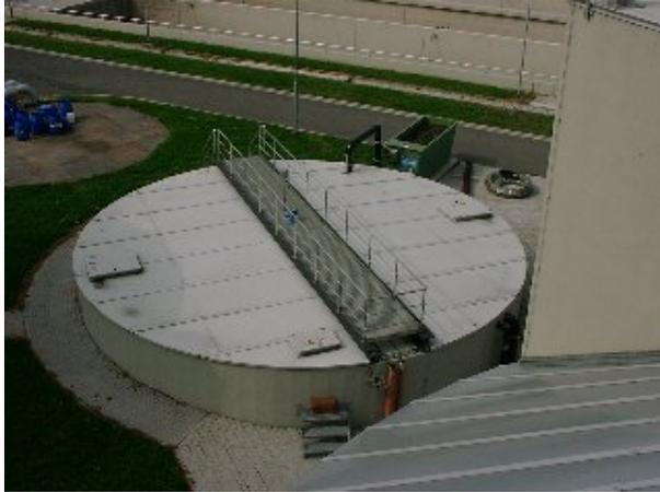
und – wie der Name schon sagt – eingedickt. Dazu ist der Behälter mit einem Krählwerk (langsam umlaufendes Gatter) und einer Wasserabzugsvorrichtung ausgestattet. Zwischen Vorklärung und Voreindicker befindet sich ein sogenannter Monohmuncher (Zerkleinerer) dessen Aufgabe es ist, den Schlamm zu homogenisieren und Grobstoffe zu zermahlen bzw. abzuscheiden.
