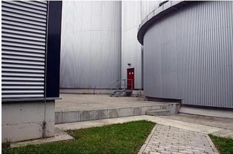
Im Faulturm werden die Schlämme aus der Vorklärung und die biologischen Überschussschlämme behandelt. Dies ist deswegen erforderlich, da die Schlämme einen hohen organischen Anteil besitzen und in unbehandelte Form extreme Gerüche entwickeln können. Dies ist bei behandeltem Schlamm nicht mehr der Fall. Man nennt diese Behandlung deshalb auch
