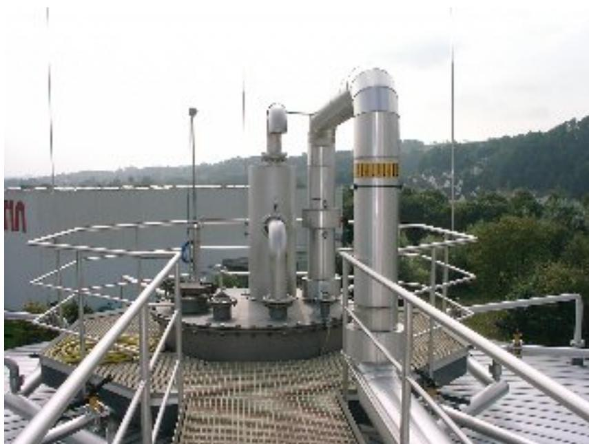
Bild: Faulturmsspitze mit Gasentnahme und Überdrucksicherung
