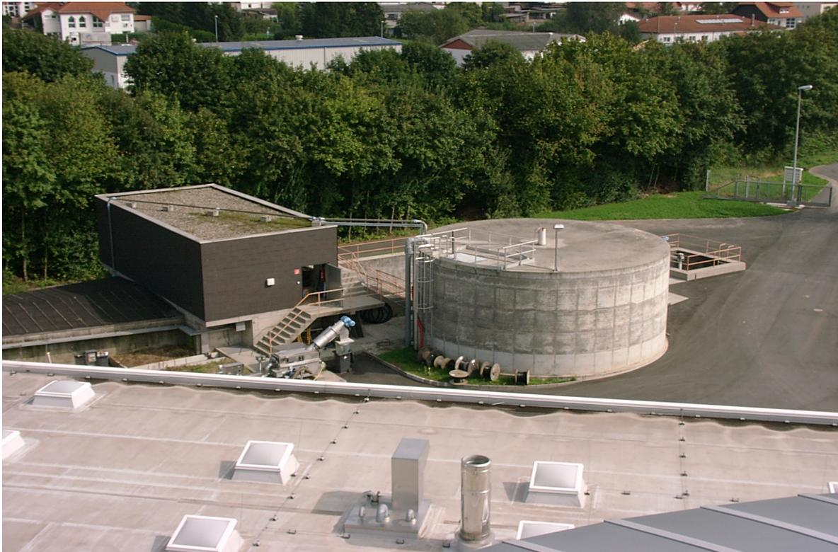
Bild: Prozesswasserbehälter (rechts)
