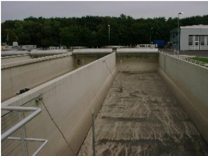
(Zwischenspeicherung). Hierzu sitzt im Ablauf der Vorklärung eine Ammoniumsonde ( $\text{NH}_4$ ), die die Konzentration des Ammoniumstickstoffs im Zulauf überwacht. Zusammen mit der Wassermenge aus den Zulaufmessungen wird ein Frachtwert berechnet und bei Überschreitung ein
