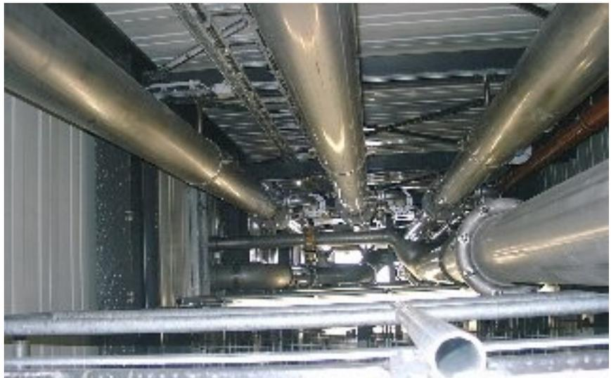
Das entstehende Klärgas (ca. 1400 m<sup>3</sup>/d) wird zu Strom- und Wärmeenergie genutzt. Neben dem Faulbehälter werden sämtliche Gebäude der Kläranlage mit der Abwärme des Blockheizkraftwerkes geheizt und zusätzlich 1.000.000 kWh Strom jährlich erzeugt.
